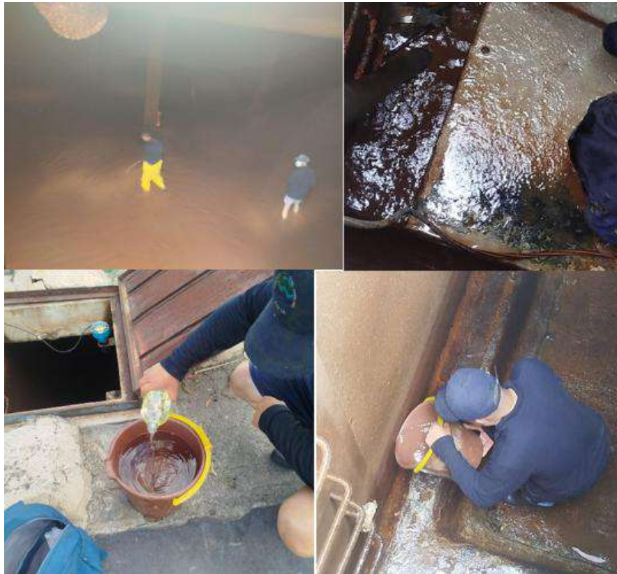
IMÁGENES DE LOS PROCEDIMIENTOS DE LAVADO Y DESINFECCIÓN DEL TANQUE
