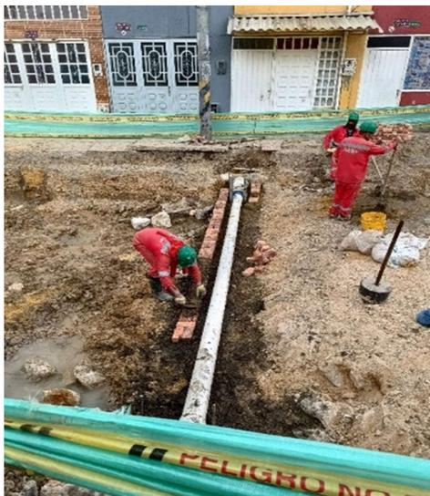
El 23 noviembre, debido a las obras de realizadas en el contrato 3517-2021 cuyo objeto es "CONSTRUCCIÓN DE VIAS PRINCIPALES DE CONEXIÓN LA COMUNA 1 DEL MUNICIPIO DE SOACHA CUNDINAMARCA ETAPA 1", se presento daño en la Tubería de 3", sobre la calle 31sur
