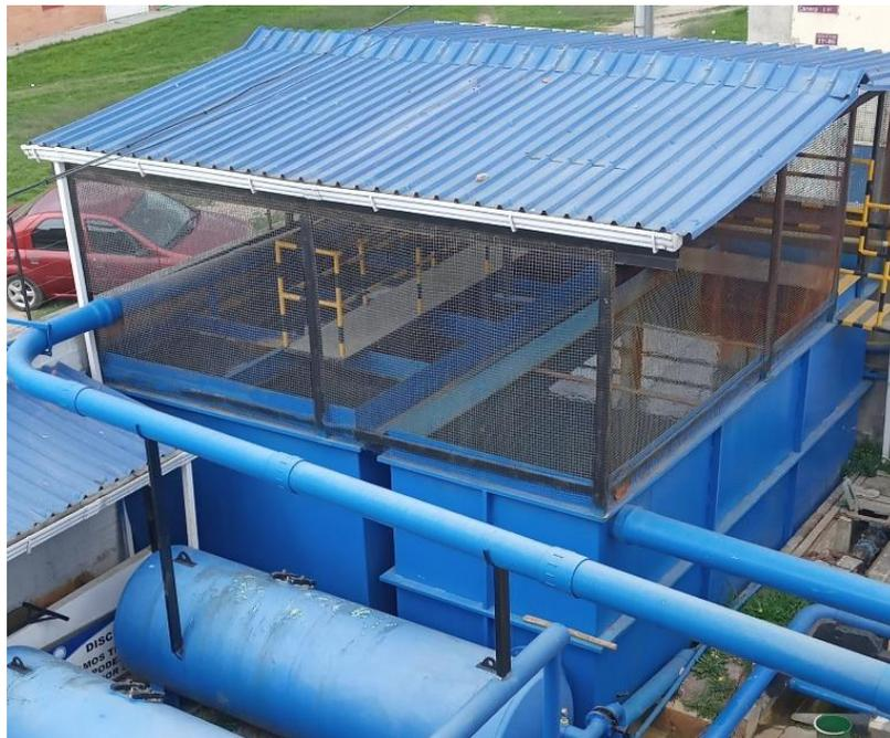
**FUENTE: E.A.A SANTA ANA E.S.P. S.A. - A LA IZQUIERDA SE OBSERVAN LAS CÁMARAS DE SEDIMENTACIÓN Y A LA DERECHA EL TANQUE CLARIFICADOR.**
