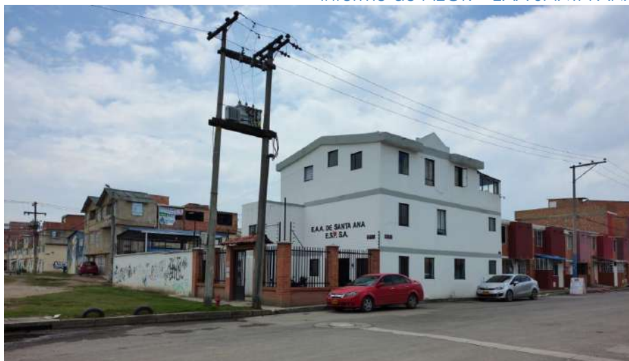
Oficinas de la empresa y Planta de Tratamiento de Agua Potable.
