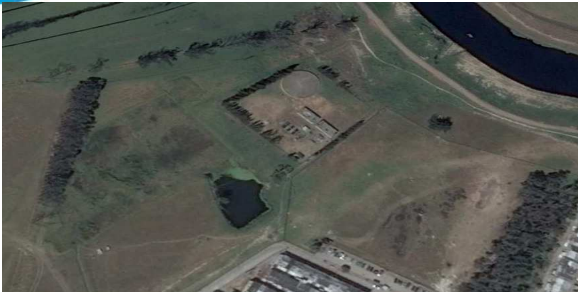
Planta de Tratamiento de Aguas Residuales – Alcantarillado Quintas de Santa Ana.
